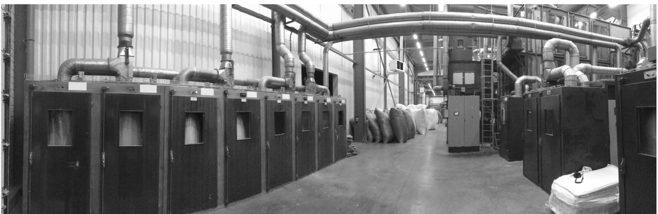
Figure 1 : vue d'ensemble de la trieuse à rénover avec cases à vide
